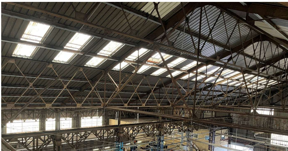
Figure 6: Hangar G – Ferme principale de la grande nef
